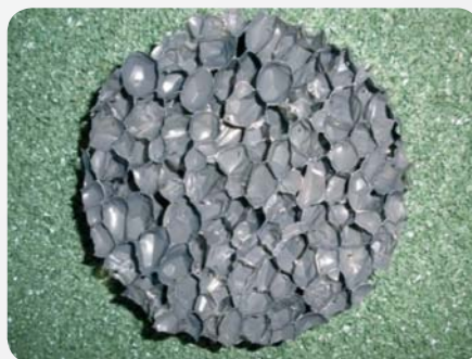
Fot. 1. Komory powietrzne w płycie (widok po zdjęciu wierzchniej warstwy)
