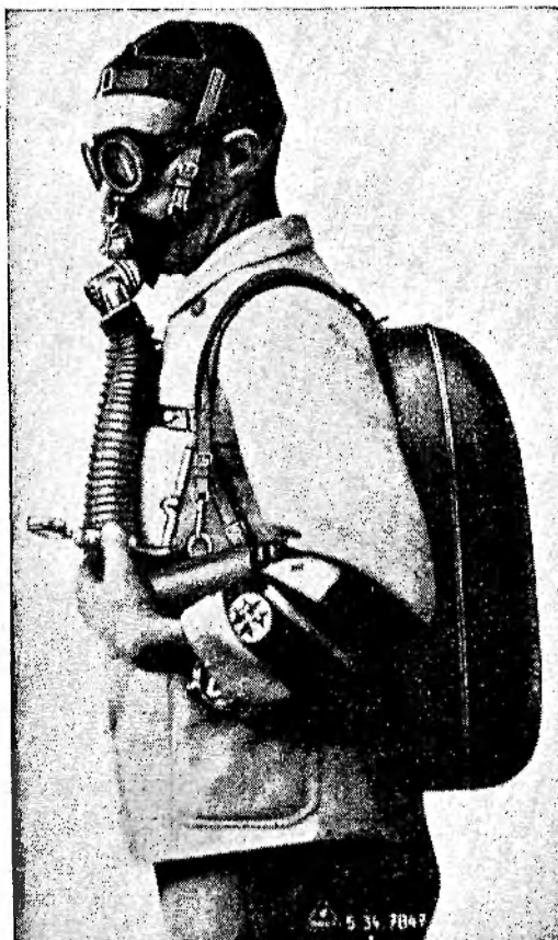
Ratunkowy aparat tlenowy wraz z maską
