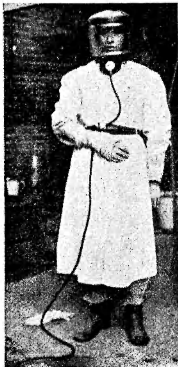
Helm syst. Van der Grinten z doprowadzeniem powietrza
